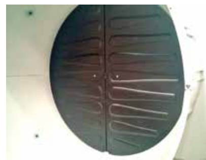
Фото 3. Заслонки BlueFan управляются автоматически и в закрытом положении почти не пропускают воздух
